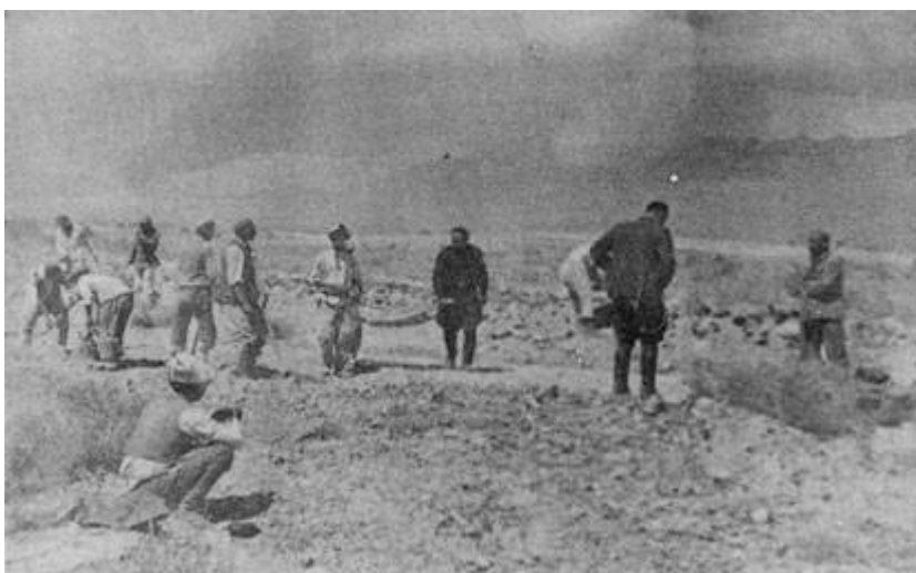
سۇ ئىنشائاتى قۇرۇلۇپ سۇ قۇيۇپ بېرىش
